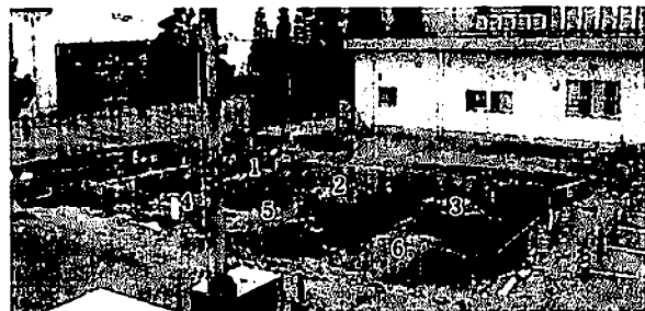
写真-1 WIBIの施工時状況
