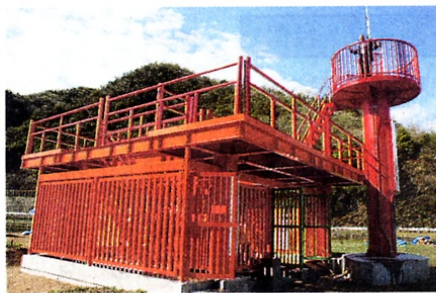
フジワラ産業が備前市に建設した津波避難タワー
