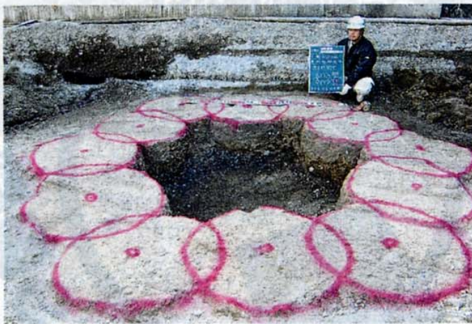
車の振動対策として施工したWIB工法の構造物。赤い印を付けているのが改良柱＝静岡市
