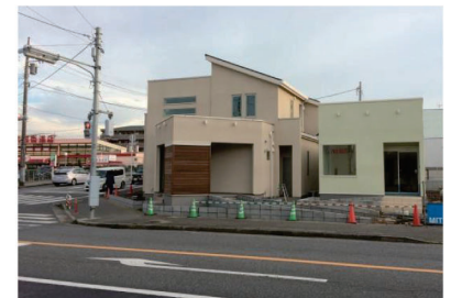
竣工後の医療施設(右が隣接する薬局)
