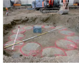
WIB工の施工状況
