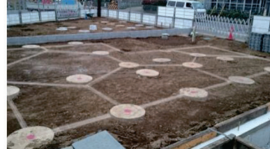
WIB工の施工状況 (A棟)
