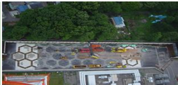
都内事業所の振動遮断WIB工事
