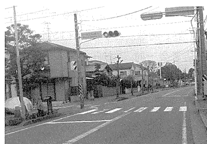
写真-1 工事施工箇所写真(着手前)
