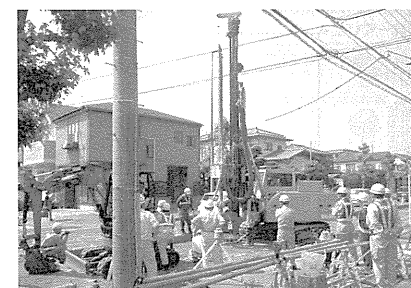
写真-2 工事施工状況写真
