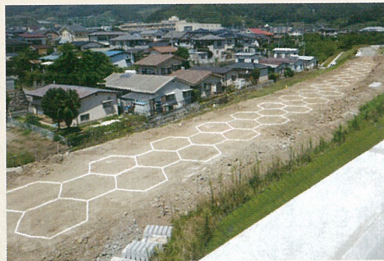
図-2 WIB工の施工状況
