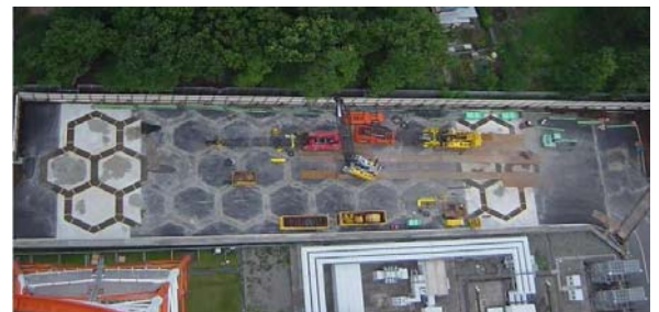
低周波(3~10Hz)を遮断 東京電力(株)事業所 平成20年3月
