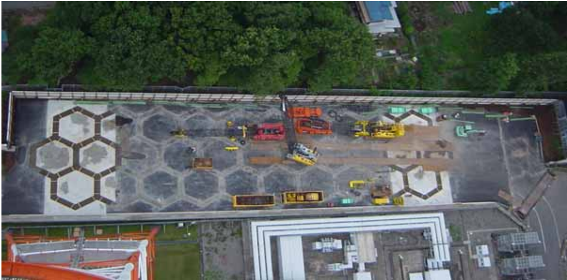
首都圏大型事業所の3～10 Hzの超低周波振動を無体感レベルに低下(東京電力(株))
