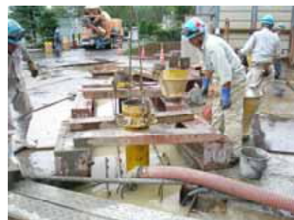
八ニカムセルの防振工事の竣工直前
