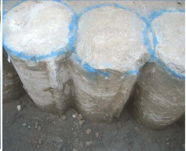
(4) 地盤改良柱の出来型、隣接改良柱のラップ状況
