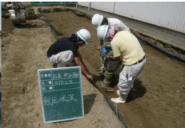
(8) WIB工の天端へ埋め戻し作業(免振層)
