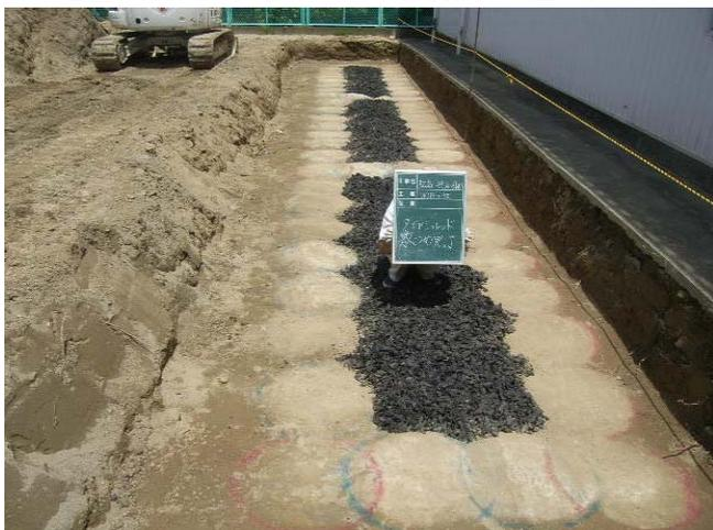
(2)地盤改良柱と高減衰材(TDA)中詰めによる複合WIB
