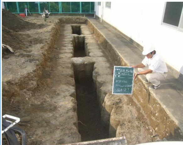
(5) 地盤改良柱壁による格子形状
