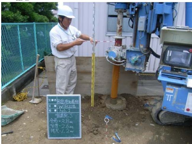
(1)地盤改良機によるセメント系固化材の注入作業
