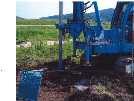
写真1 地盤改良柱の施工
