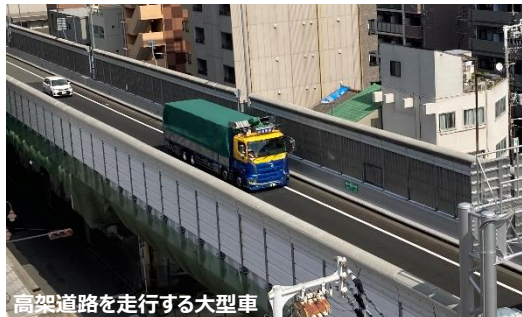
高架道路を走行する大型車
