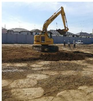
WIB工の施工前後で重機による起振試験を実施した。
